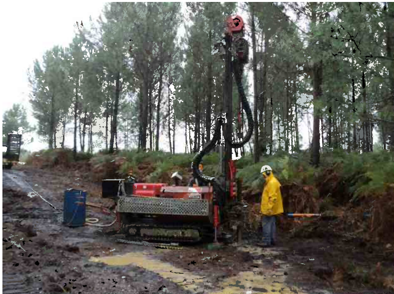
Forage en cours PZ4
